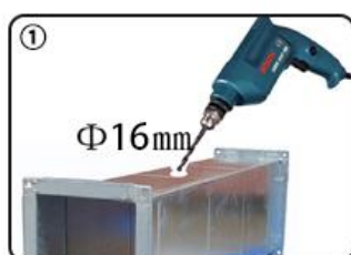
在排风管上打一个直径16mm的孔
