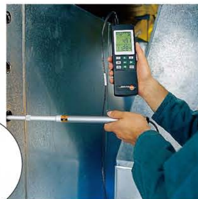
空调通风系统调试
