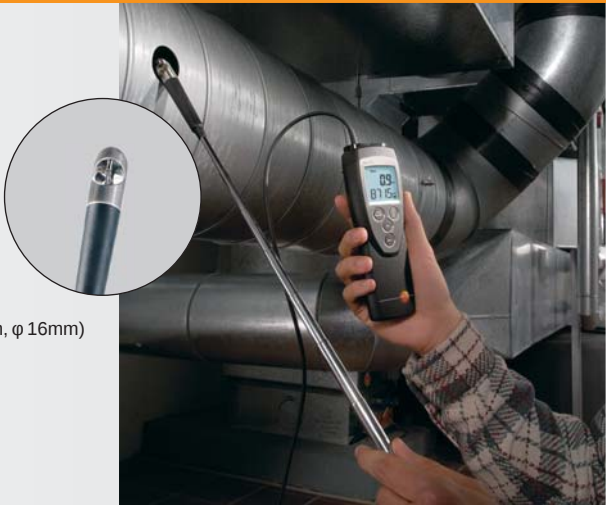
监测通风管道的风速
