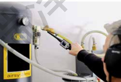
带聚焦管泄漏检测仪远距离检测泄漏
