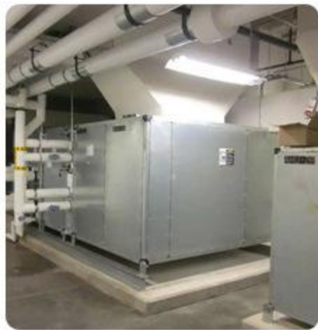
HVAC暖通空调
